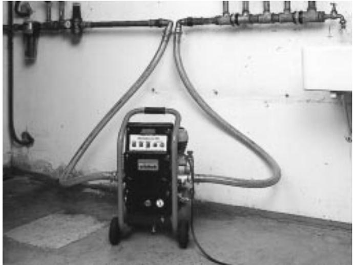
**Für die Spülung metallener Leitungen oft unentbehrlich: Der Spülkompressor fürs intermittierende Spülen mit Wasser und Druckluft [3]**
