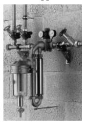
außerdem Vor- und Nachdruck-Manometer. Außer dem Filtersieb wird bei dieser Station auch die Filtertasse regelmäßig durch Streifenbürsten gesäubert. Der Einbau ist sowohl in senkrecht als auch in waagerecht verlegter Leitung möglich. Erhältlich ist das Gerät in den Anschlußgrößen 1" bei einer Durchflussleistung von 4,2 m<sup>3</sup>/h und  $1^{1}/_{4}$ " bei 4,6 m<sup>3</sup>/h Leistung. Perma-Trade 71229 Leonberg Tel. (0 71 52) 9 39 19-0 Fax (0 71 52) 9 39 19 15
