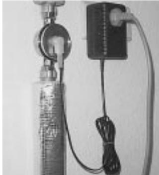
am Sensor 35 °C warmes Wasser gemessen wird. Das Sensorteil wird in die Warmwasserversorgungsleitung mit einem Abstand von etwa 1,5 m vom WW-Speicher eingebaut. Das Steuerteil wird zwischen Stecker und 230-V-Steckdose des Pumpenanschlusses gesteckt.
