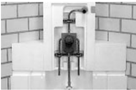
Einbau der Wannenfüll- und Brausearmatur in Unterputzausführung und Ablängen des Wanneneinlaufanschlusses
