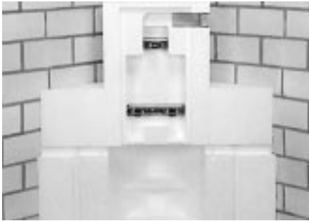
Das Ober- oder Montageteil wird auf dem Unterteil des Eckmoduls festgeklebt
