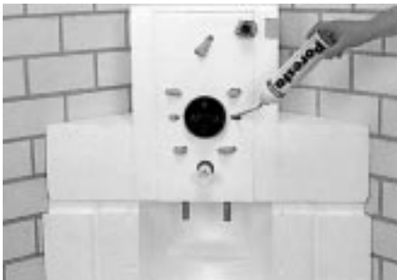
Anschließen der Armatur, Dichtheitskontrolle und Abdecken der Armatur mit anschließendem Ausschäumen
