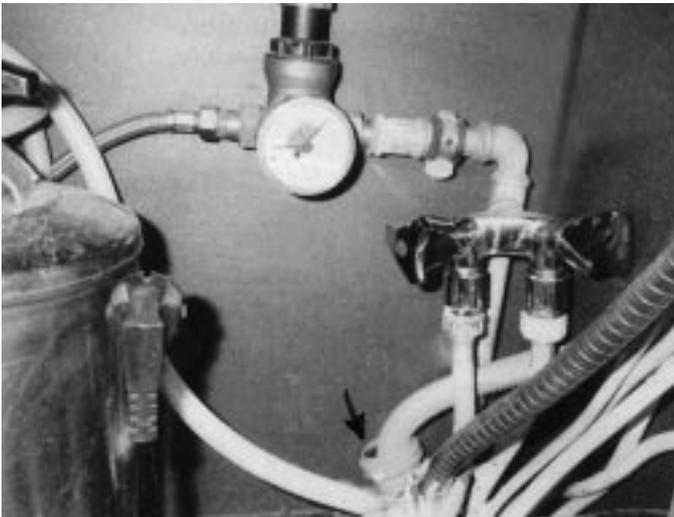
**Fetthaltige Abwässer verstopften die Abwasserleitung, sodass rückstauendes Wasser aus den ungenügend abgedichteten Ablaufeinführungen (s. Pfeil) austrat, durch den Deckendurchgang lief und Waren im darunter befindlichen Raum beschädigte**
