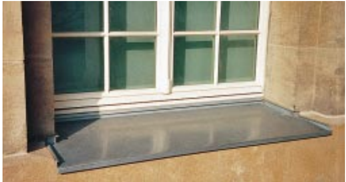
Fensterbänke werden auch heute noch oft mit Blech abgedeckt. Die gezeigte Abdeckung aus Zink ist mittels Bitumen-Kaltkleber befestigt (Bild: Enke-Werk)
