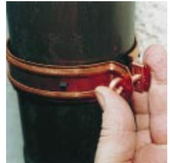
**Das Fallrohr wird durch Eindrücken der Ringschraube in den Federstahlclip festgeklemmt**
