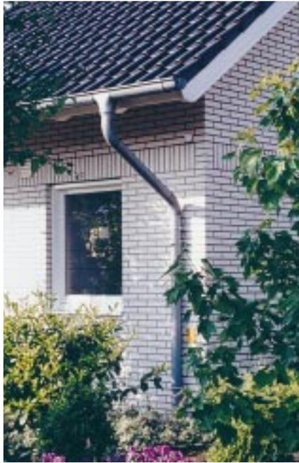
**Wo Regenwasser über Fallrohre in die Grundleitung abgeleitet wird, werden Rohrschellen benötigt, um die Rohre am Baukörper zu befestigen**
