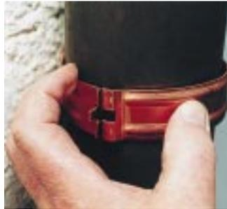
**Am Baukörper erfolgt nach dem Anbringen des Stiftes, dem Einklicken der Schelle und Einlegen des Fallrohres das Verbinden der Schellenhälften durch Einrasten**
