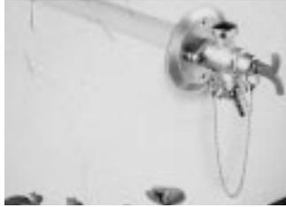
ein Rücksaugen von Schmutzwasser über einen angeschlossenen Schlauch bei Druckabfall. Alle wasserführenden Teile bestehen aus entzinkungsarmem Messing. Das Ventil ist für Wände mit bis zu 500 mm Dicke einsetzbar.
