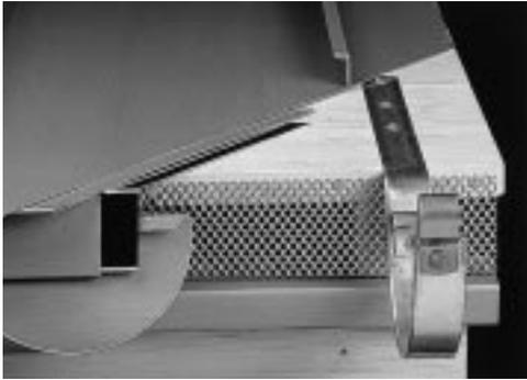
bei gibt die Zahl 63 den freien Lüftungsquerschnitt in Prozent an. Trotzdem verhindert es das Eindringen von Vögeln und Kleintieren. Hergestellt aus Titanzink ist es in der Tafelgröße 1000 x 2000 mm mit einer Dicke von 1,0 mm lieferbar. Der Hersteller empfiehlt das Rautenlochblech für Zuschnittbreiten von 200 mm im nicht einseharen Bereich
