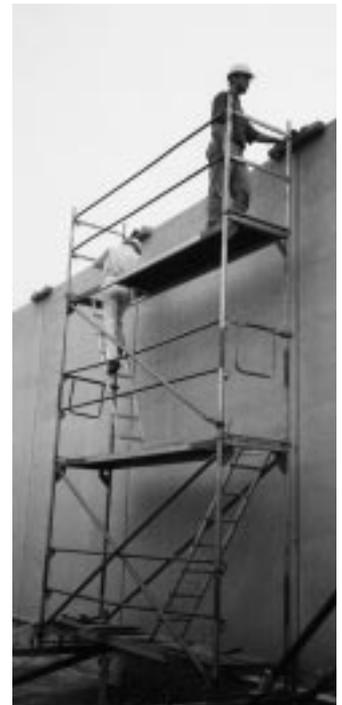
**Sicher nach oben geht's im Gerüst, besonders wenn die Durchstiegsklappen versetzt angeordnet wurden [1]**
