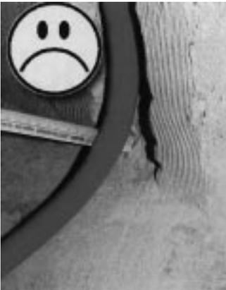
**Bei direkt in den Wandschlitz führenden Heizungsanbindungen kann es zu einer unzureichenden Überdeckung des Rohres im Estrich- und Wandbereich kommen**
