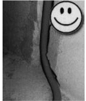
**Verbreitert man das Schlitzende zur Seite hin, kann der Rohrbogen bodenparallel in den Schlitz und erst dort nach oben geführt werden**
