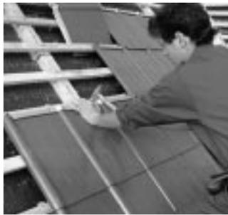
**Farbeschichtetes Aluminiumblech ist in Tafeln und Bändern, aber auch in vorgefertigten Dachelementen erhältlich**
