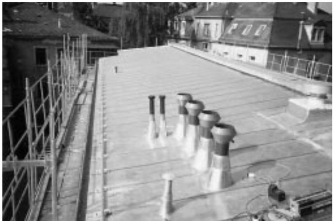
**Dachbekleidungen aus Metall haben den Vorteil, dass sich Durchdringungen und Anschlüsse sicherer herstellen lassen als bei manch anderen Werkstoffen**
