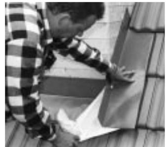
**Bleiblech wird heute hauptsächlich für Einfassungen und Anschlüsse verwendet, wobei es Halbzeuge gibt, die nicht nur farbbeschichtet sondern auch mit einer Klebemasse versehen sind (Bild: Jung + Lindig)**
