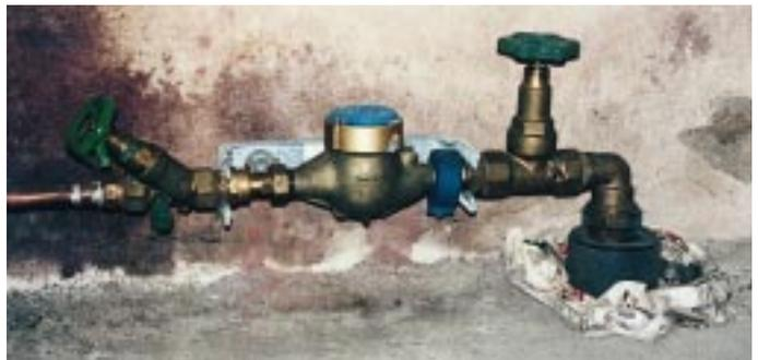
**Im Altbau ist der Hausanschluss oft mit nur dem Nötigsten ausgestattet: Absperrarmatur ohne Entleerung, Wasserzählerbügel und Wasserzähler, Absperrarmatur mit Entleerung und Rückflußverhinderer (kombiniert)**
