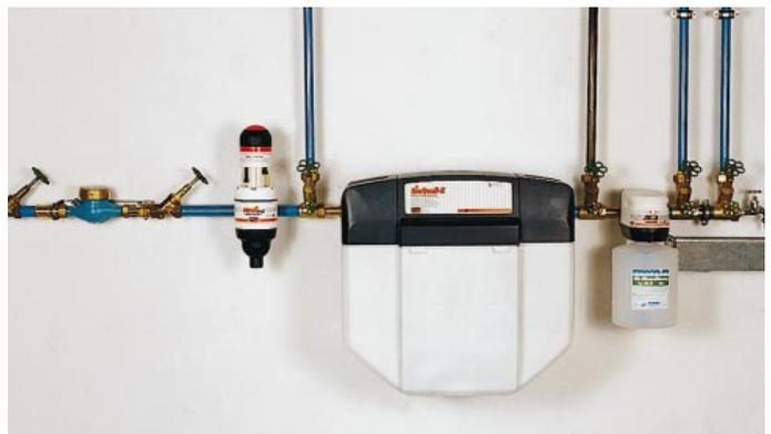
**Enthärtungsanlagen sollten erst bei Wässern des Härtebereichs 4 eingebaut werden; Dosieranlagen kommen nur nachträglich zum Einsatz, wenn an bestehenden Anlagen Korrosionserscheinungen auftreten [7]**
