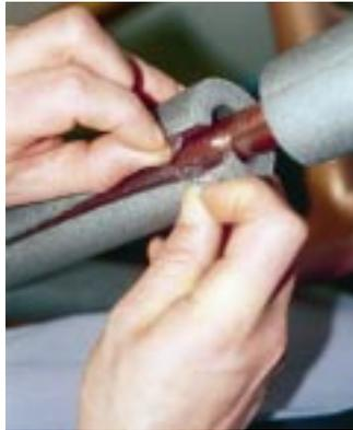
**Das Dämmen mit selbstklebenden Schläuchen verkürzt die Verarbeitungszeit, da das Schlitzten der Schläuche und das Auftragen des Klebers entfällt**
