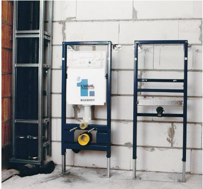
**Für die Einrichtung des Badezimmers in einem Ahle-ner Mehrfamilienhaus werden vorerst die blauen Duo-fix-VWI-Elemente und die GIS-Schachtkonstruktionen separat montiert**
