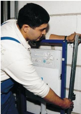
**Über zwei Nasen lassen sich die Adapterschienen in seitlich an den Rahmen der Montageelemente befindliche Langloch-Aussparungen einhängen . . .**
