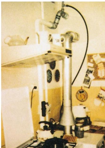
Das korrodierte offene Ausdehnungsgefäß wurde entfernt und an dessen Stelle ein Schlauchanschluss (o.) angebracht
