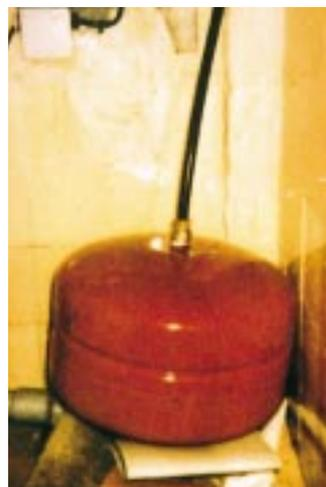
Der Schlauch führt von dem Anschluss an der Vorlaufleitung unter die Tischplatte zum MAG, das lose in die Zimmerecke gelegt wurde
