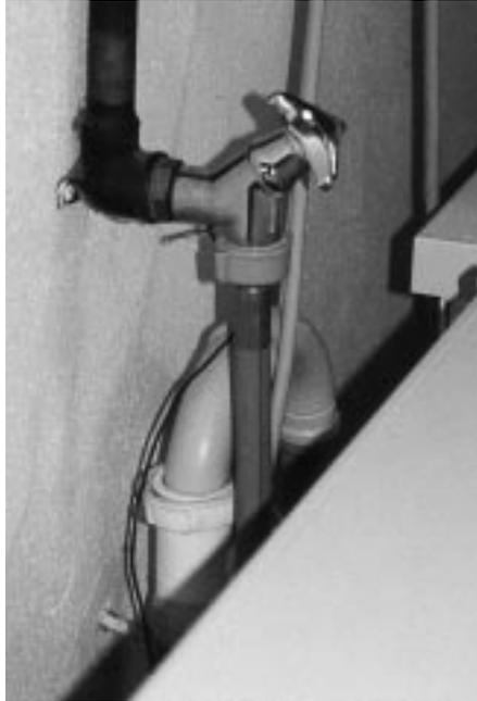
Ein Schlauchanschlussventil mit Rückflussverhinderer und Rohrbelüfter schützt zwar die Trinkwasserleitung gegen Rücksaugen, nicht aber die Wohnung gegen ein Platzen des Schlauches . . . [6]
