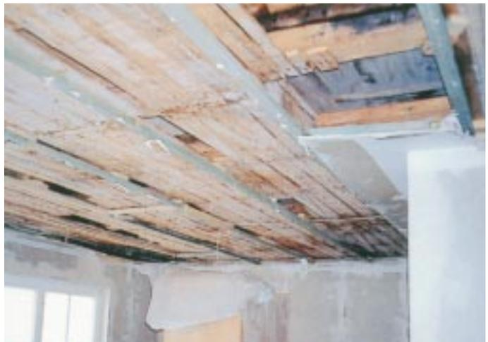
**Aufgrund des Wasserschadens musste die Deckenkonstruktion freigelegt und aufwendig getrocknet werden**
