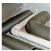
Wenn z. B. Abwasserrohre am Vorwandinstallationsgestell anliegen (linkes Bild, unten) oder in Mauerbzw. Deckendurchgänge direkt mit Mörtel eingegossen werden (rechtes Bild), kommt es unausweichlich zur Übertragung von Körperschall in die Nachbarräume
