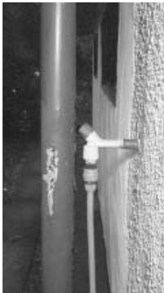
rohre – aus verzinktem Stahlblech hergestellt. Zur Werterhaltung hat der Hausherr Rinne und Rohr regelmäßig gestrichen. Doch nach fünfzig Jahren begann die Farbe an einer Stelle des Fallrohres plötzlich abzublättern. Bei näherer Untersuchung stellte sich heraus, dass das Rohr an einer Seite von oben bis unten nahezu durchkorrodiert war. Der Grund dafür war nicht der saure Regen. Denn dann wäre die Zerstörung
