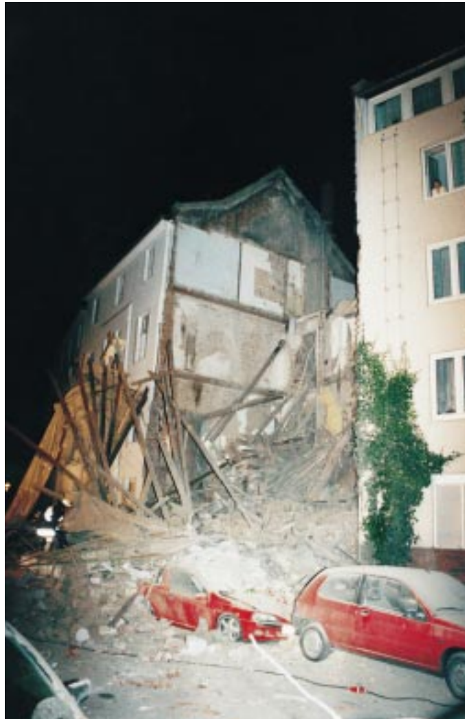
Ein entfernter Verschlussstopfen DN 40 und die Folgen. Das Mehrfamilienhaus in der Krahestraße stürzte ein. Sechs Menschen starben unter den Trümmern [1]
