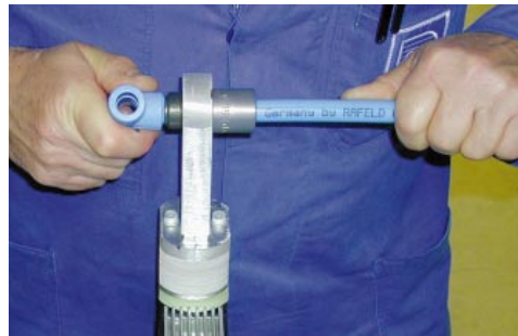
Am Heizelement-Schweißgerät werden die Muffe des Fittings und das Rohrende gleichzeitig bis zum Erreichen des plastischen Zustandes erwärmt
