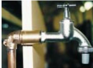
**Gefährdet für Spannungsrisskorrosion sind Anschlussverlängerungen, wenn sie z. B. in der Durchführung durch die Gipskartonplatten angeordnet sind (r.), da die Ringfuge nach dem Verfliesen meist mit Silikon verschlossen wird. Doch auch freiliegende (l.) sind schadengefährdet, wenn ammoniakhaltige Reinigungsmittel verwendet werden [4]**
