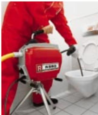
**Rohrreinigungsmaschinen sind für Rohre bis zu DN 150 gedacht und können mit Spiralen bis zu 22 mm Durchmesser versehen werden**
