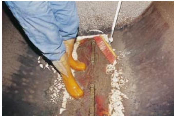
**Um eine Korrosion des Stahl-Heizöltanks durch eingedrungenes Wasser zu vermeiden, werden Opferanoden eingebaut**
