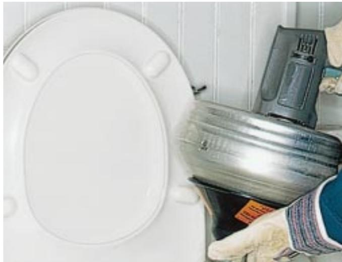
**Selbst wenn die Reinigung vom Sanitärobjekt aus durchgeführt wird . . .**
