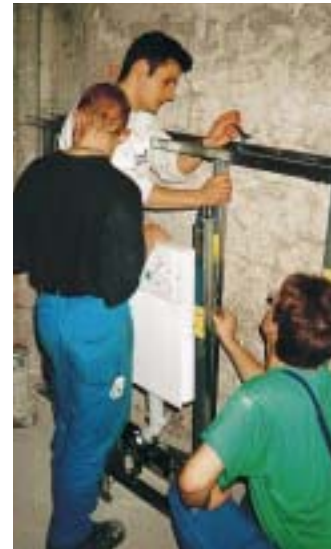
... an dem sich die Installateure beim Einbau der Vorwandinstallations-Elemente orientierten
