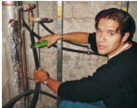
Kalt- und Warmwasserleitung wurden aus Polyethylen in Presstechnik verlegt . . .
