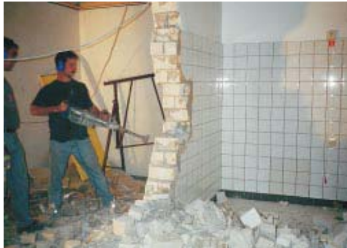
Nicht nur die Jungs vom Berufsgrundbildungsjahr Bau beteiligten sich am Abbruch der Zwischenwand . . .
