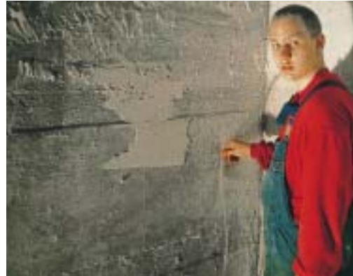
Die Neuinstallation begann mit der Übertragung des Meterrisses ...
