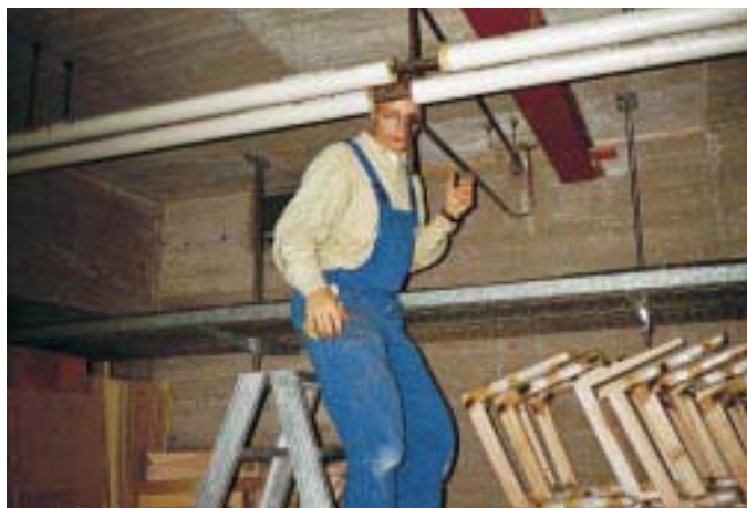
. . . während die Heizkörper-Anschlussleitungen traditionell in Stahlrohr ausgeführt wurden (neben den Anschlussleitungen ist der neue Unterzug sichtbar)
