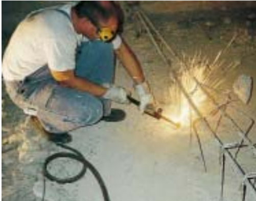
... Nach Einbau eines Unterzuges in der darunterliegenden Garage konnte auch der Bewehrungsstahl entfernt werden
