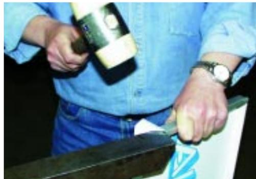
Abschließend kann man die vorderen Ecken der Putzkanten aus Sicherheitsgründen im Winkel von 45° abschneiden. Seitlich auf die Fensterbankabdeckung auftreffendes Regenwasser lässt sich durch einen schrägen Schnitt der Traufkantenecke zur Traufkante hin führen.
