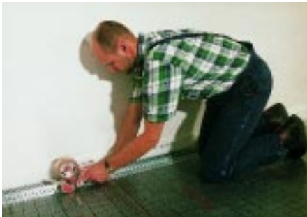
Gegen die Wand wird das FBH-System mit einer speziellen Randdämmung abgeschottet
