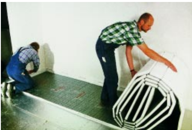
Über Hartschaumplatten werden die Grundplatten für die Heizungsrohre abgerollt
