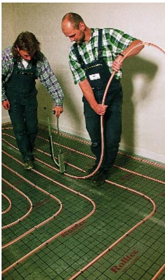
Die vernetzten Polyethylen-Heizungsrohre werden auf der gerasterten Plattenfolie festgetackert
