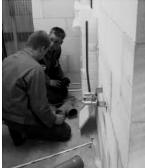
Die Sanitär-Installateure bei der Arbeit in der Nassbau-Koje . . .
