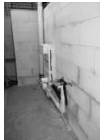
. . . und die fertiggestellte Installation
