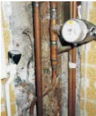
**Blei-Kupferrohr-Mischinstallation, zahlreiche Flussmittelreste und eine eigenwillige Rohrbefestigung**
