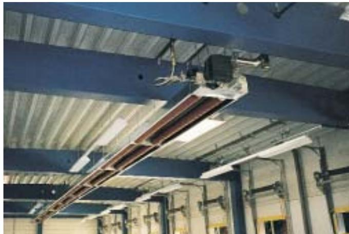
**Dunkelstrahler in Kompaktbauweise haben ein U-förmig gebogenes Strahlrohr [2]**
