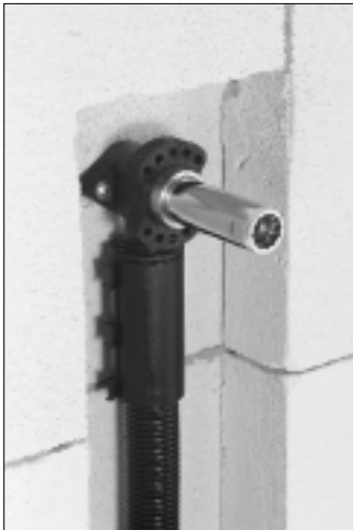
Die Schutzkappe verhindert Verunreinigungen des Adapters bei den Putz- und Fliesenarbeiten [1]
