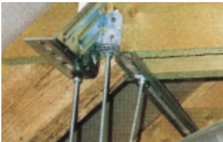
**Die Befestigung des Klimagerätes erfolgte an den Dachsparren**
