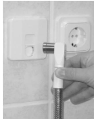
absperren und ein Eindringen von Fremdkörpern sicher verhindern. Forderungen, die durch die Sicherheitsgassteckdose Sentry GC erfüllt werden.
