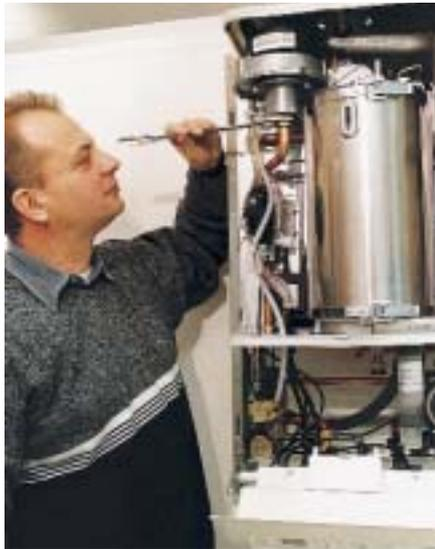
**Die Überwurfmutter des Gasanschlusses wird gelöst, um bei der Umstellung von kleiner auf große Leistung die Abdeckung der Mischkammer zu entfernen**
