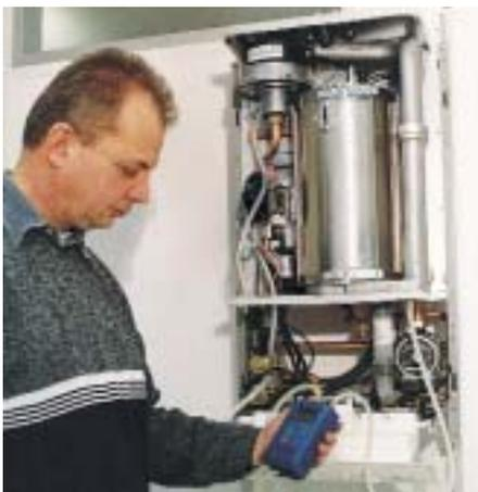
**Nach Austausch des Drosseleinsatzes und der Gasdrosselblende müssen Gas-Luft-Verband und CO<sub>2</sub>-Gehalt neu justiert werden**
