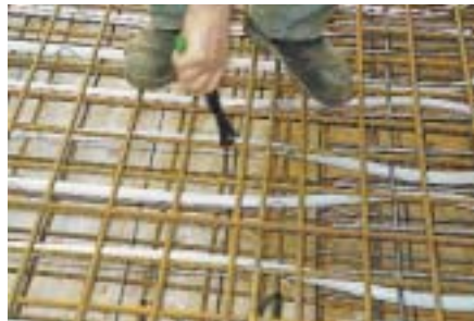
Die Aufzugshalter werden in das Modul eingehakt und an die obere Bewehrung angehängt
