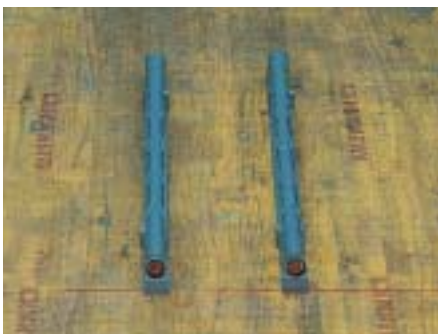
Nach Fertigstellung der Schalung werden die Deckendurchführungselemente aufgenagelt
