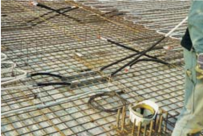
Sind die Anbindeleitungen in die DDE eingeschoben, wird ein Schutzrohr über das Rohr gestülpt
