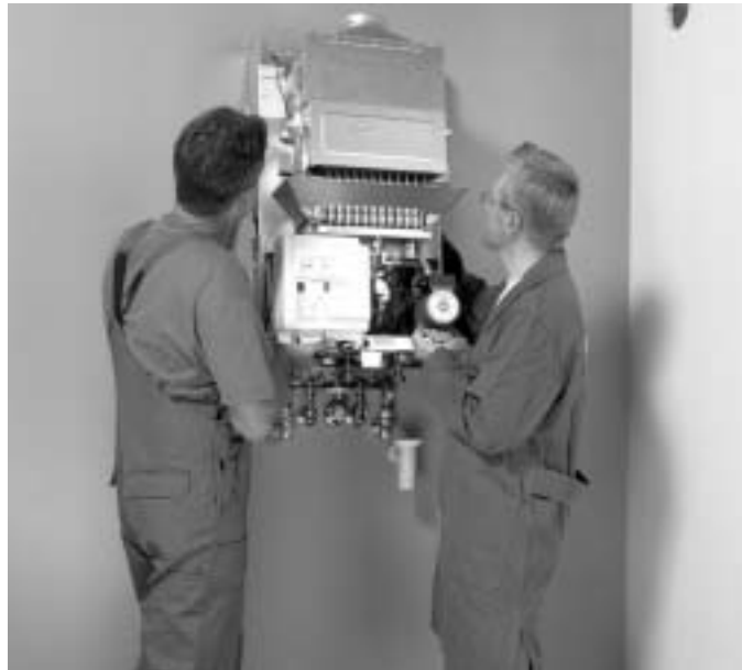
Der Wandheizkessel wird ohne Verkleidung in die Wandhalterung eingehängt
