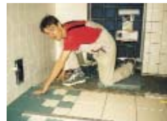
. . . und Christian Knolle machte sich an die Plattierung des Fußbodens
