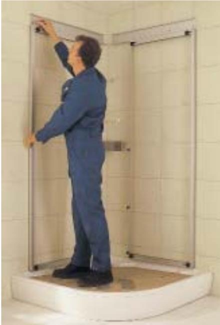
**Die Rahmenprofile der Kabine werden bündig auf die Wannenkante aufgesetzt und verschraubt**
