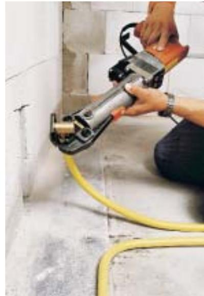
graten und zu kalibrieren. Die Pressverbinderhülse und der Fitting werden dann aufgesteckt und die Verbindung verpresst. Eine Technik, die es erlaubt, zügig zu arbeiten und – nach Aussagen des Herstellers – auch umfangreichere Anlagen kostengünstiger zu erstellen als wie mit klassischen Materialien. Gerade Letzteres ist möglicherweise ein Aspekt, der künftig über sein und nicht sein der häuslichen Gasinstallation entscheiden wird.
