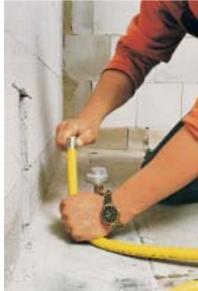
**... die Pressverbinderhülse wird aufgesteckt, ...**
