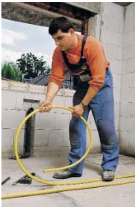
**Die Verarbeitung „von der Rolle“ minimiert Rohrverbindungen und verkürzt die Montagezeit**
