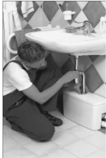
DN 40. Beide Produkte verfügen über eine eingebaute Rückschlagklappe.
