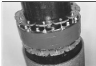
geschlossen, im Brandfall von den aktivierten Modulen geschützt und bleibt im Ringraum liegen. Rund 60 Minuten bei ca. 1000 °C werden Flammen und Rauchgase zurückgehalten und die Rohrdurchführung bleibt elastisch und stabil. Die Druckdichtigkeit bleibt erhalten.
