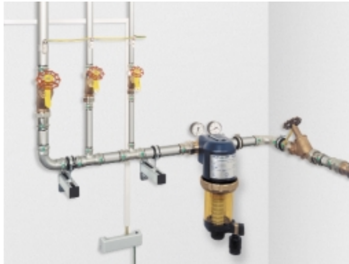
Edelstahlrohre gewinnen in der Trinkwasserinstallation immer mehr an Bedeutung
