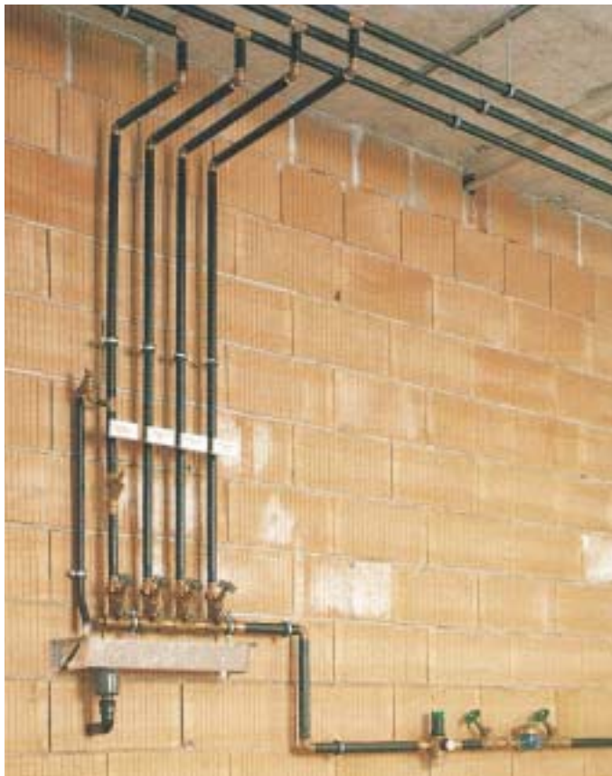
Metallverbundrohre können wie Metallrohre installiert werden und sind korrosionssicher wie Kunststoffrohre
