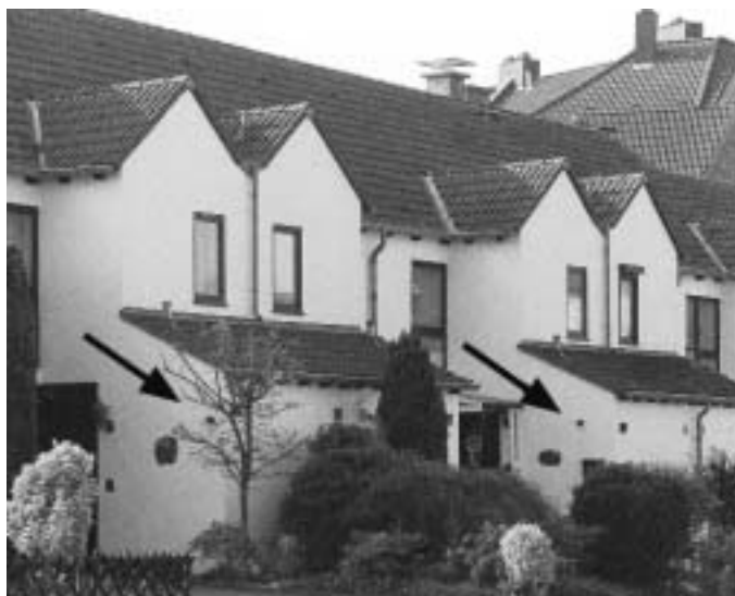
Diese Häuser wurden aus Kostengründen ohne Schornstein gebaut und C_{13} -Geräte eingesetzt: Ein Missbrauch der Ausnahmeregeln
