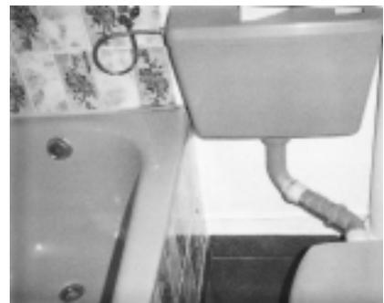
stens wollen wir nicht reden. Doch da ist noch der Anschluss des Spülkastens an die Kloschüssel, der mittels HT-Rohren hergestellt wurde anstatt wenigstens mit einem Rohr der gleichen Farbe wie Spülkasten, Toilettensitz und Badewanne, wenn schon die Installation eines Druckspülers nicht möglich gewesen sein sollte.
