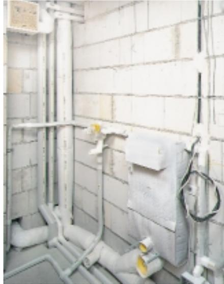
Vor Ausmauerung müssen die Schallerzeuger mit Dämm-Formteilen versehen werden
