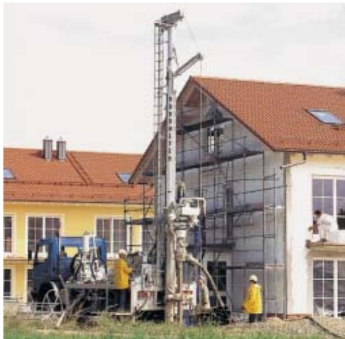
**Das Setzen der Erdsonden erfordert aufwändige Bohrarbeiten, die an die Ölsuche erinnern**
