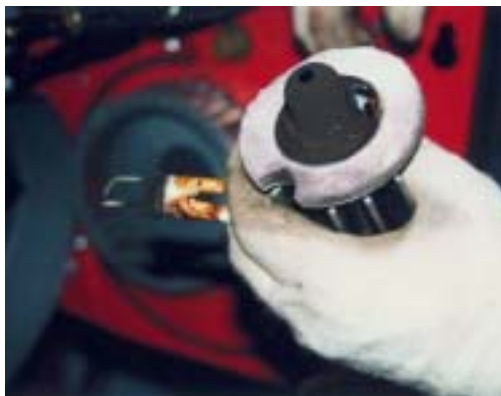
Auch die Ölbrennerdüse und die Zündelektroden haben eine Reinigung nötig
