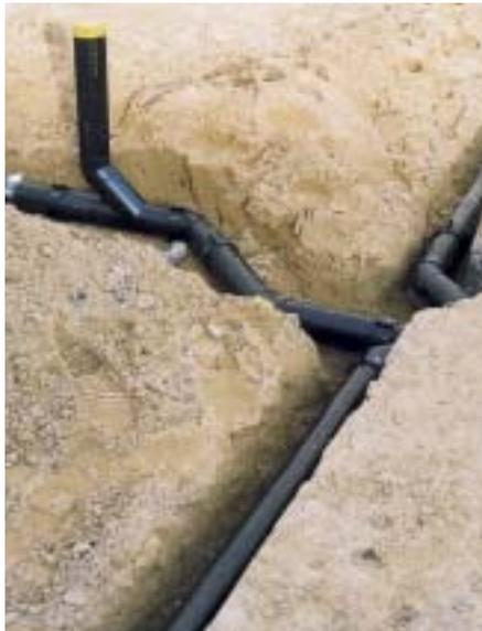
**Werden liegende Abwasserleitungen installiert, muss das errechnete Gefälle genau eingehalten werden**
